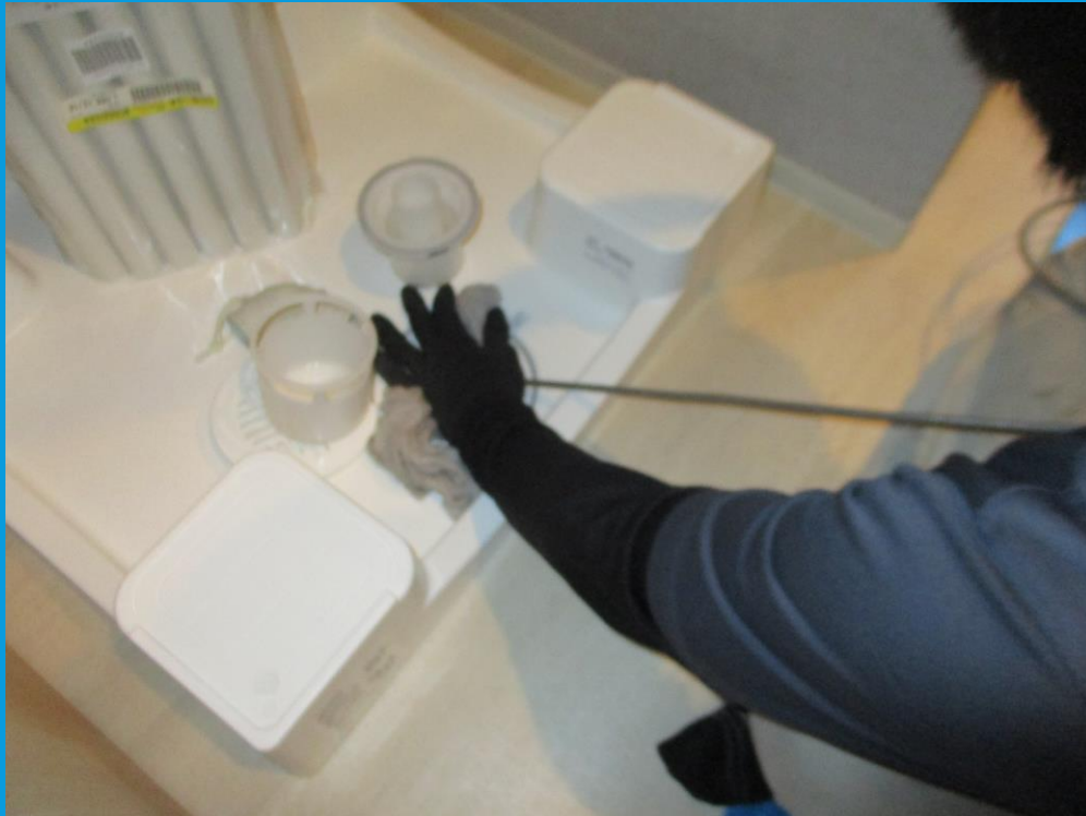
洗濯機排水洗浄
