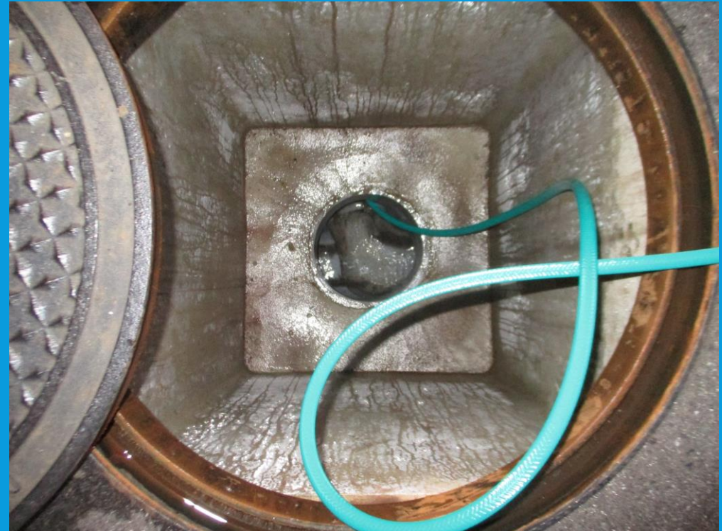
共用横引き管、横主管の洗浄
